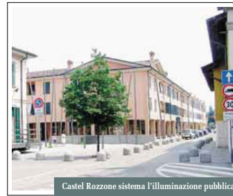
Castel Rozzone sistema l'illuminazione pubblica
